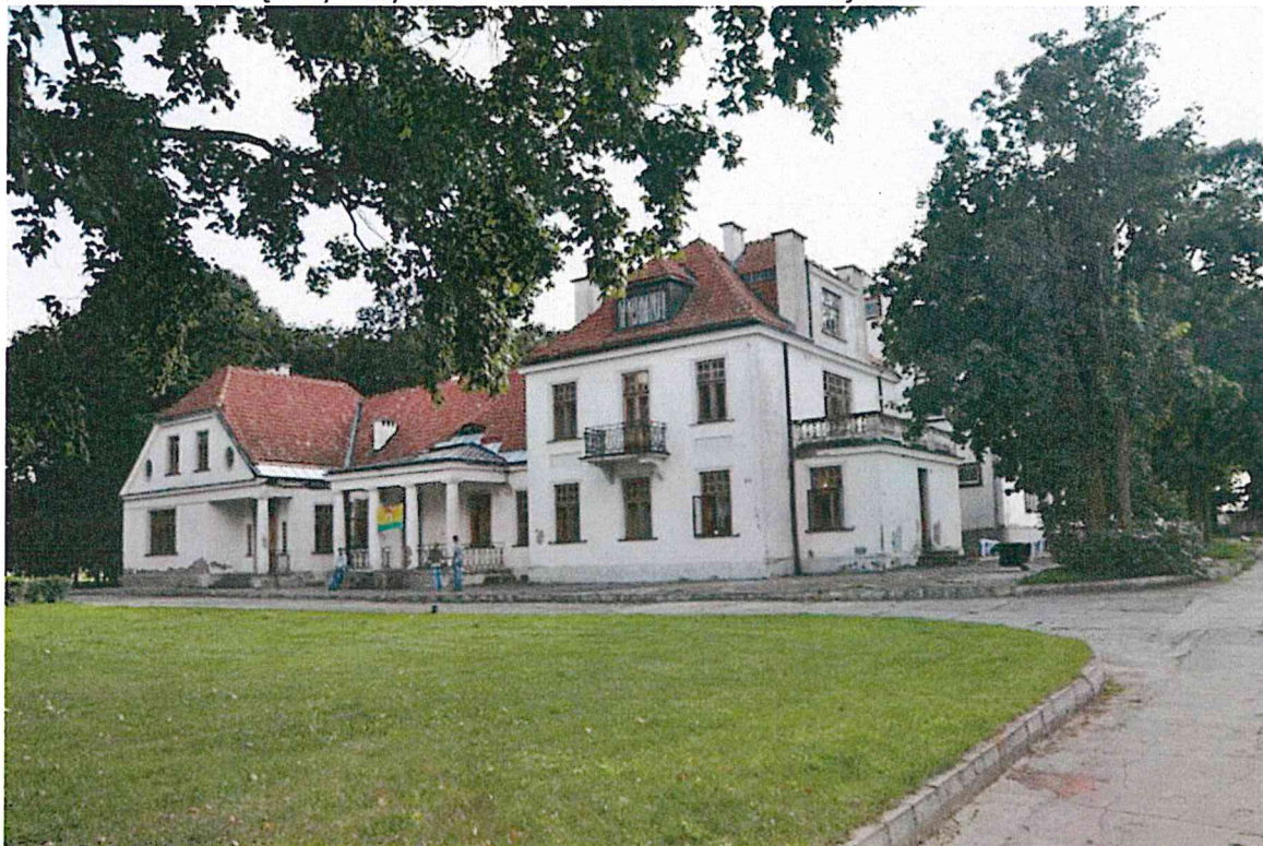
Foto 1. Widok zewnętrzny budynku b. Domu Dziecka w Lubieniu Kujawskim
